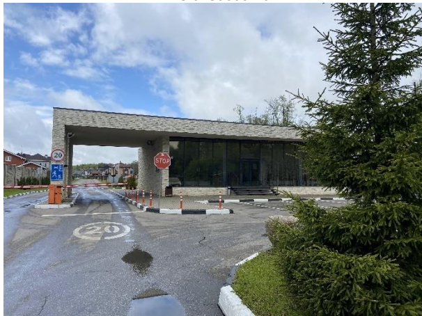
Фото 7. Въездная группа - 1-этажное строение кад. № 77:18:0180609:323 и земельный участок: 77:18:0180609:764
